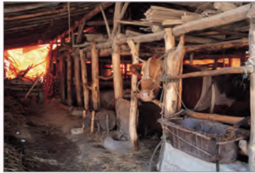
축사 คอกปศุสัตว์ 축사 지붕을 점검하거나 수리합니다. ตรวจสอบสภาพและซ่อมแซมหลังคาคอกปศุสัตว์
